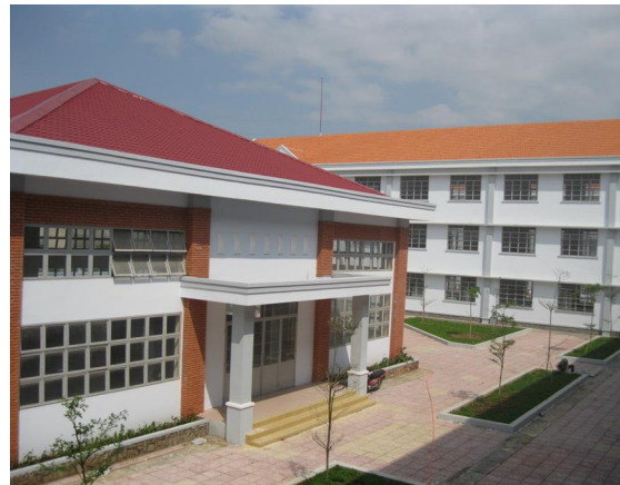
Công trình Trường Bình An
