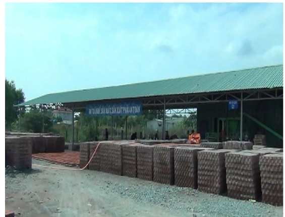
Xưởng sản xuất gạch bê tông
