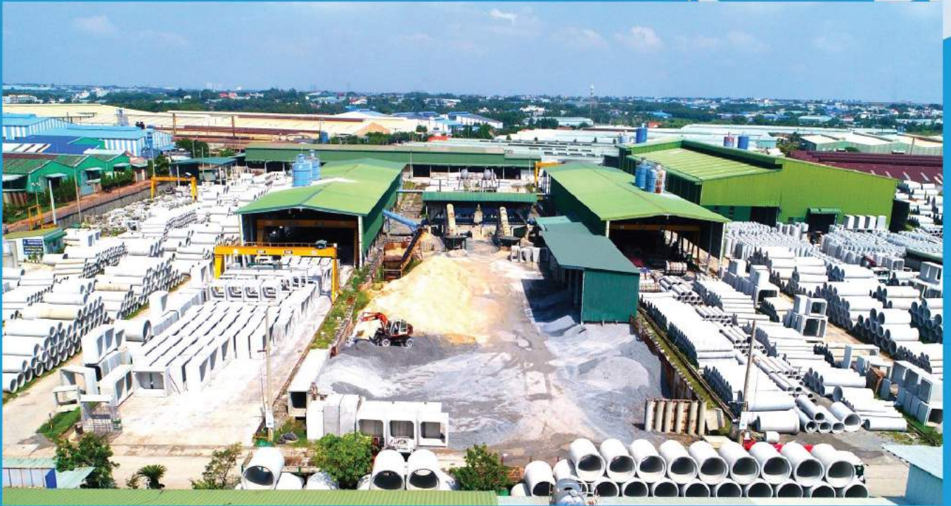
NHÀ MÁY CỐNG BÊ TÔNG THẠNH PHƯỚC
